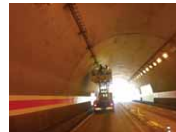
上り線トンネル延長実測 (昼間車線規制)
