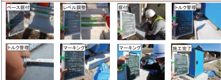
坑口分電盤設置
