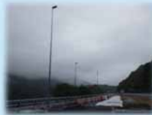
江府IC Cランプ道路照明
