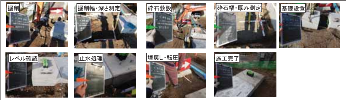
坑口分電盤基礎設置(下り線)
