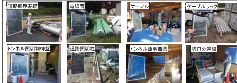
材料検査 立会者：古屋施工管理員
