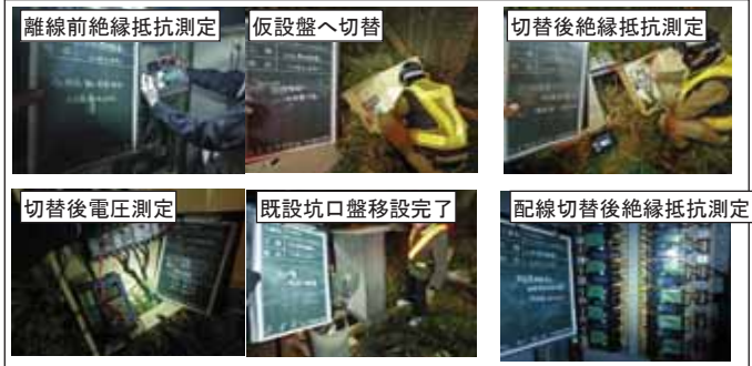
既設坑口分電盤移設(上り線)
