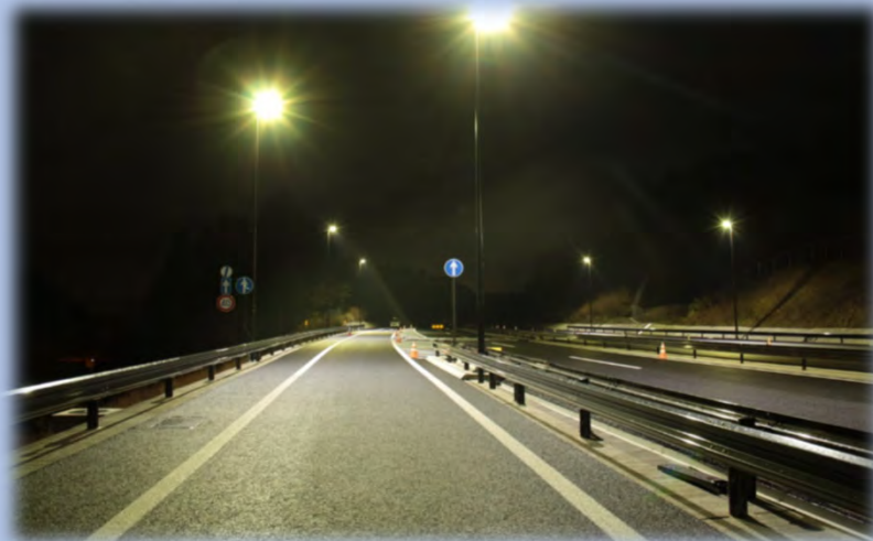
大田朝山IC道路照明
