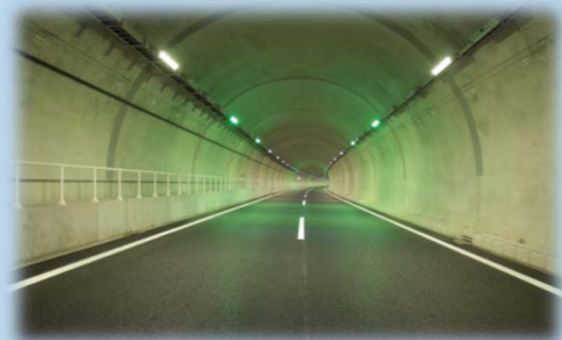
六石山トンネル サイン緑
