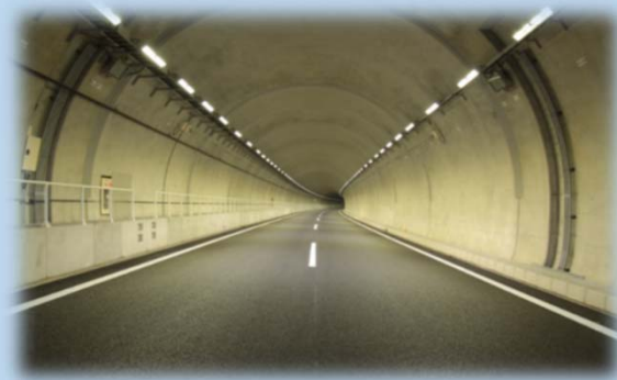
六石山トンネル 通常照明
