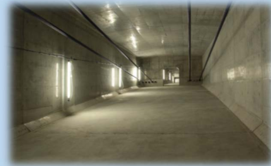
猪名川橋 桁内照明
