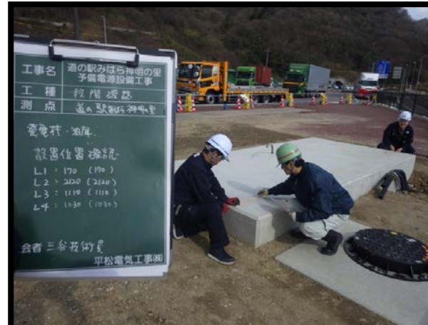
機器設置位置確認（燃料油庫）
