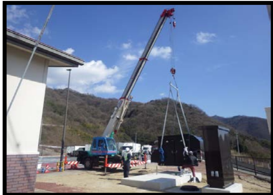
5) 発電設備設置
