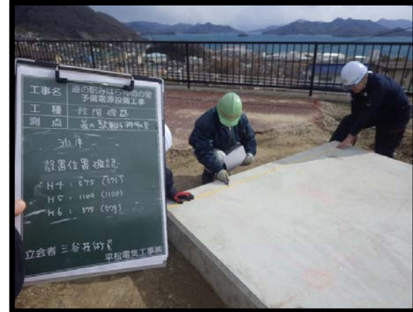
機器設置位置確認（発電機）
