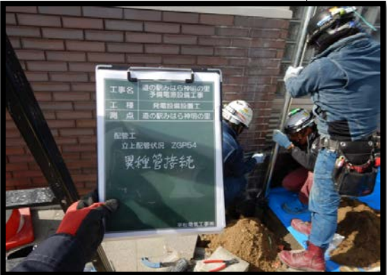
4) 配管・配線工
