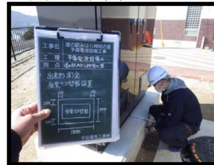
受電切替盤設置位置
