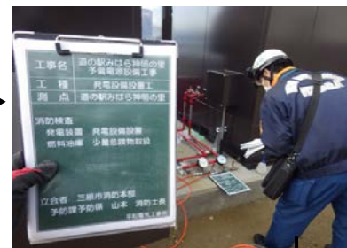
気密試験（消防検査）
