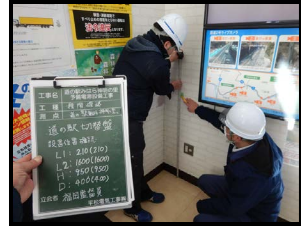
機器設置位置確認（道の駅切替盤）
