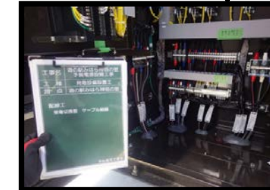
8) 配管配線結線
