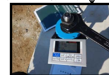
4) アンカー引張試験
