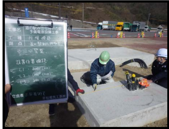
機器設置位置確認（受電切替盤）
