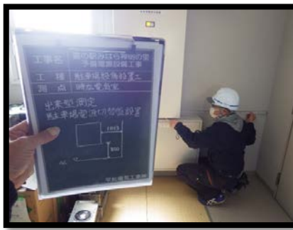
駐車場電源切替盤設置位置
