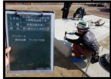
3) アンカー打設
