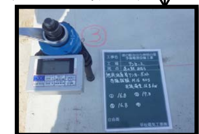
4) アンカー引張試験
