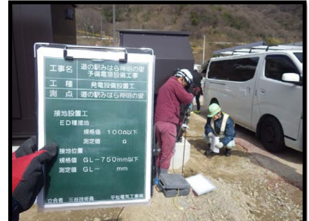
接地設置工
