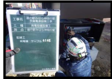
8) 配管配線結線
